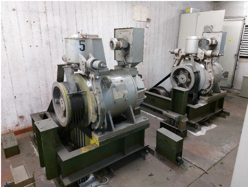
Figura 4: Foto di una porzione del locale macchine degli ascensori n. 3-4-5-6 collocato sulla copertura del corpo torre.
