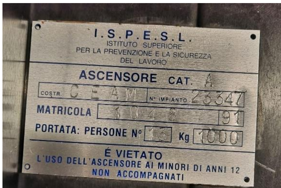
Figura 6: Vecchia targa impianto ascensore n.3
